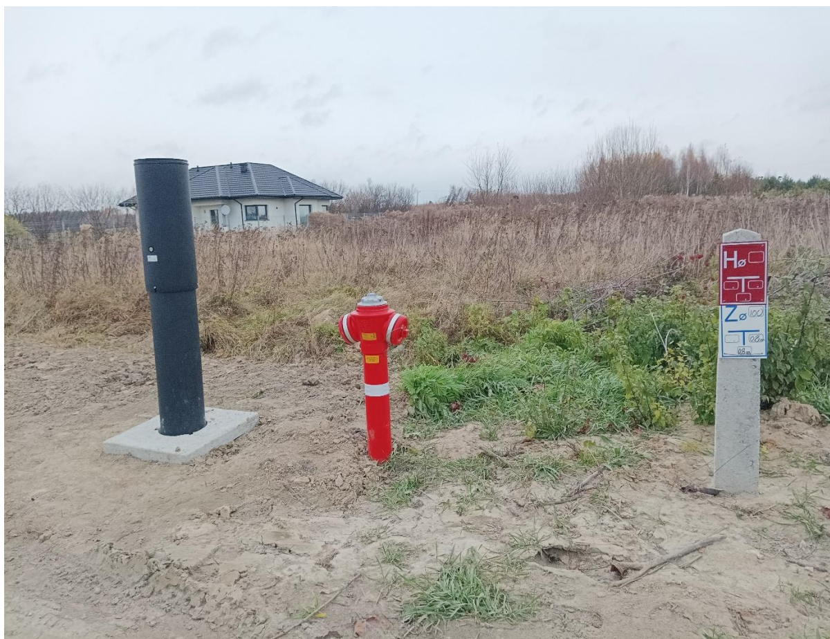
Słupek telemetryczny zamontowany na przebudowanym wodociągu w Mirówku.
